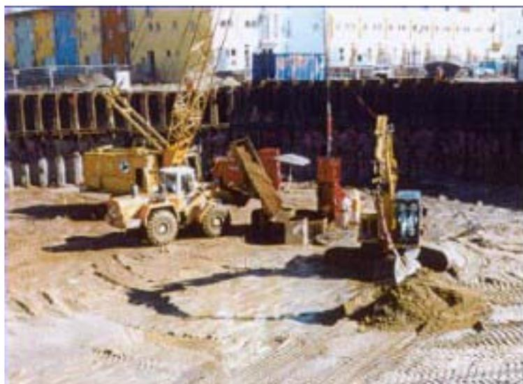
**Abb. 2: Verfüllen der Waben mit Radlader von sanierten Flächen**
