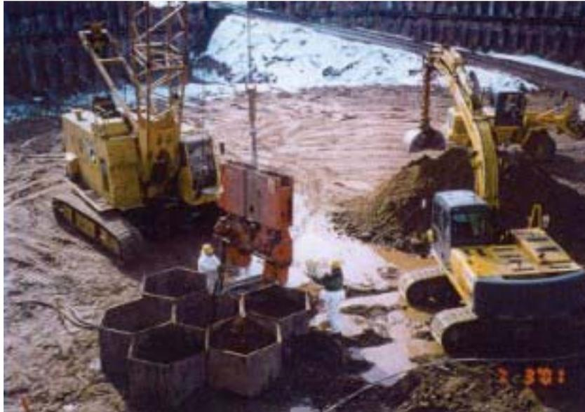
**Abb. 1: Bodenaushub aus den Waben mit Greifer und Zwischenlagerung des Aushubs auf nicht sanierten Flächen**
